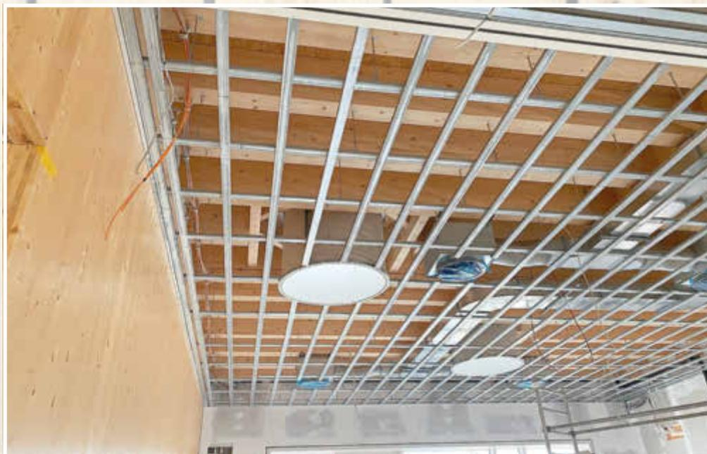
Verkleidung der Fassade und der Deckenbau
